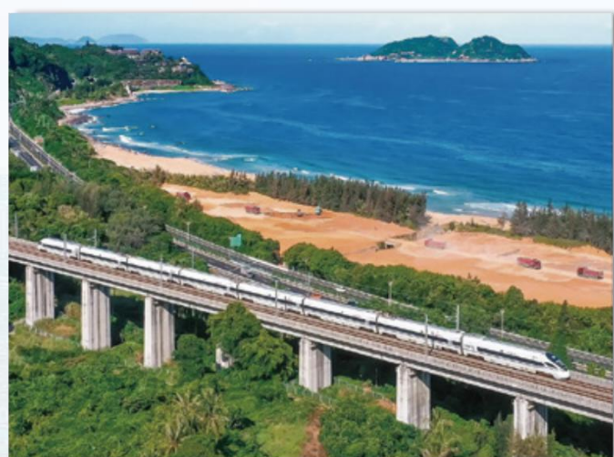
海南环岛高速铁路
