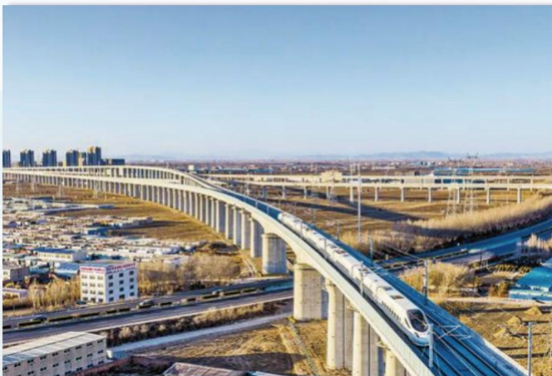
京唐城际铁路
